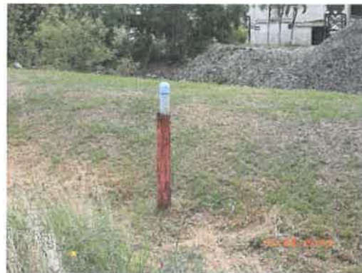
รูปที่ 2-14 Monitoring Well เขตอุตสาหกรรมทั่วไป ระยะที่ 1 บ่อ 2
