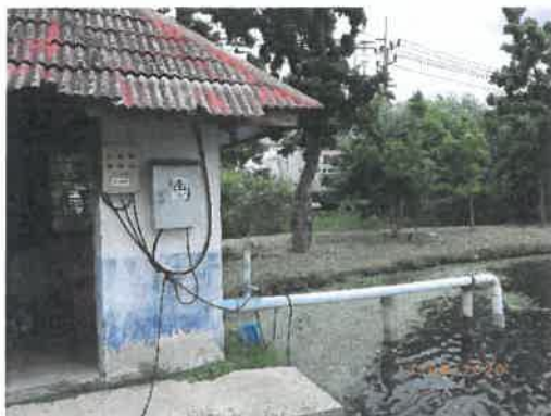
รูปที่ 2-8 การติดตั้งเครื่องสูบน้ำจากคูหนองน้ำรอบนิคมฯ
