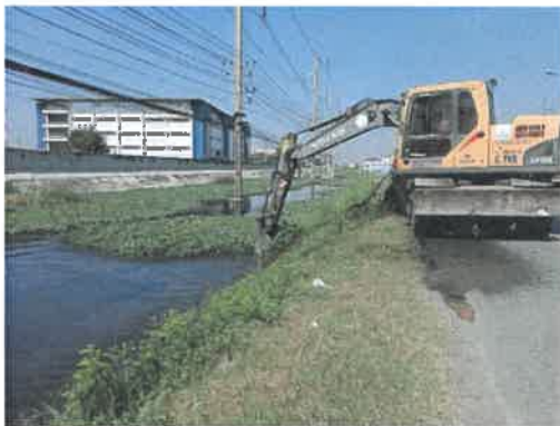
รูปที่ 2-11 การขุดลอกคูระบายน้ำภายในโครงการ
