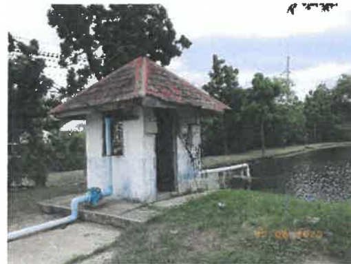
รูปที่ 2-8 การติดตั้งเครื่องสูบน้ำจากคูหนองน้ำรอบนิคมฯ
