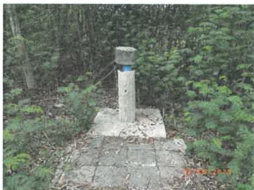
รูปที่ 2-18 Monitoring Well เขตอุตสาหกรรมทั่วไป ระยะที่ 2 บ่อ 3
