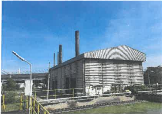
รูปที่ 2-4 เตาเผาขยะมูลฝอยของนิคมอุตสาหกรรมบางปะอิน ที่มีความสูงของปล่อง 20 เมตร
