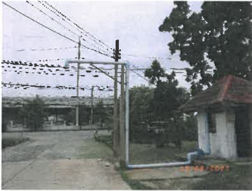
รูปที่ 2-9 การติดตั้งจุดรับน้ำที่ผ่านการบำบัดแล้ว
