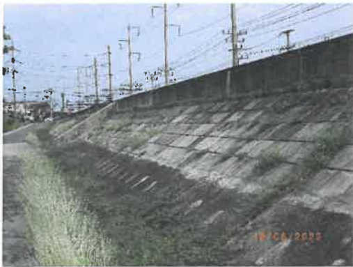
รูปที่ 2-2 ระบบป้องกันน้ำท่วม
