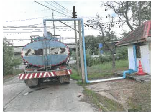
รูปที่ 2-9 การติดตั้งจุดรับน้ำที่ผ่านการบำบัดแล้ว
