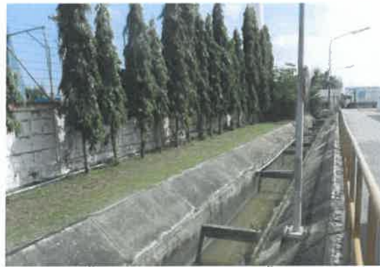
3) คูพวงน้ำภายในนิคมฯ ก่อนระบายทิ้งออกสู่ภายนอก
