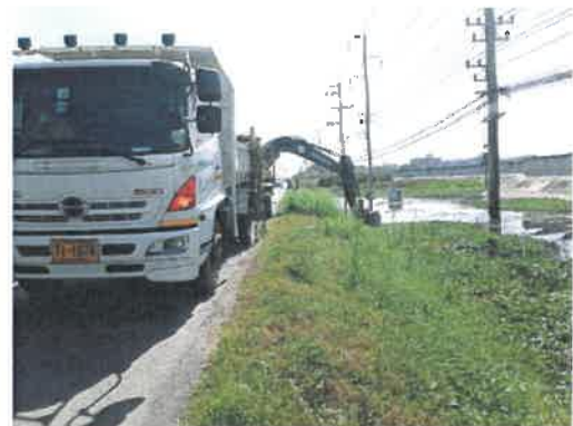
รูปที่ 2-11 การขุดลอกคูระบายน้ำภายในโครงการ
