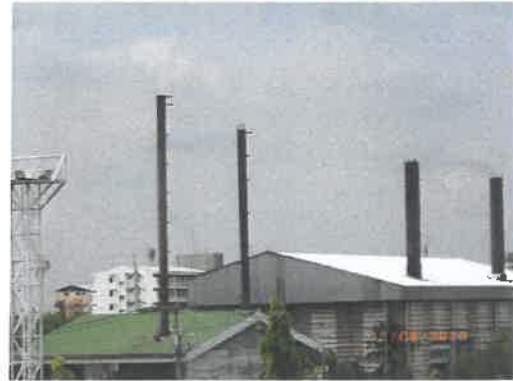
รูปที่ 2-4 เตาเผาขยะมูลฝอยของนิคมอุตสาหกรรมบางปะอิน ที่มีความสูงของปล่อง 20 เมตร
