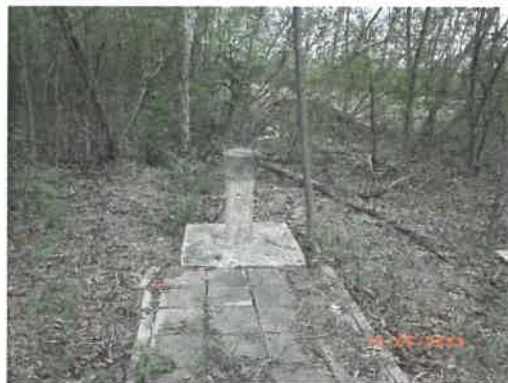
รูปที่ 2-16 Monitoring Well เขตอุตสาหกรรมทั่วไป ระยะที่ 2 บ่อ 1
